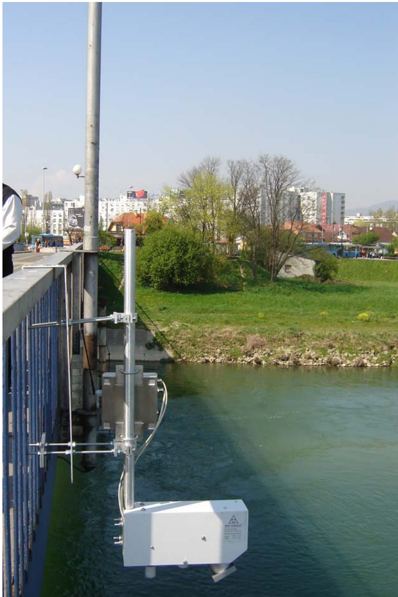
Foto 2. SIMK® uređaj postavljen na starom Savskom mostu, u Zagrebu
