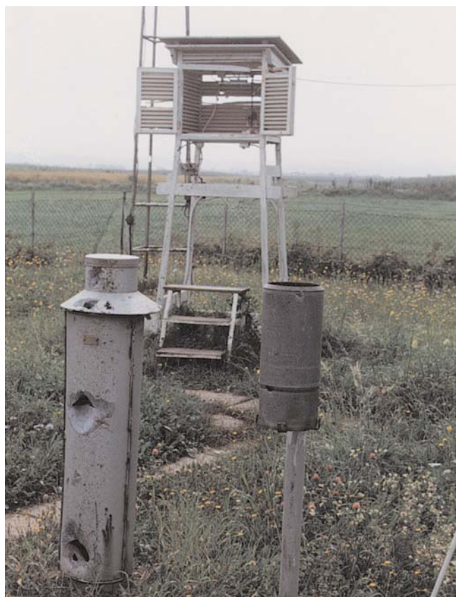
Slika 2.6. Postaja u Varaždinu, oštećena u Domovinskom ratu (1991.)
