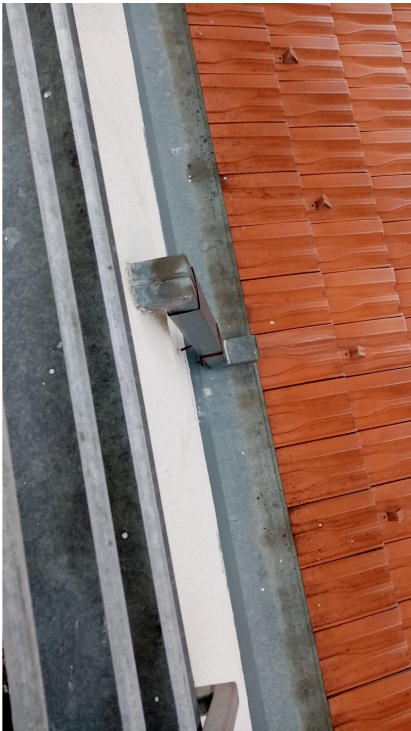
VELIKA TERASA -ODVOD OBORINA NA KOSI KROV
