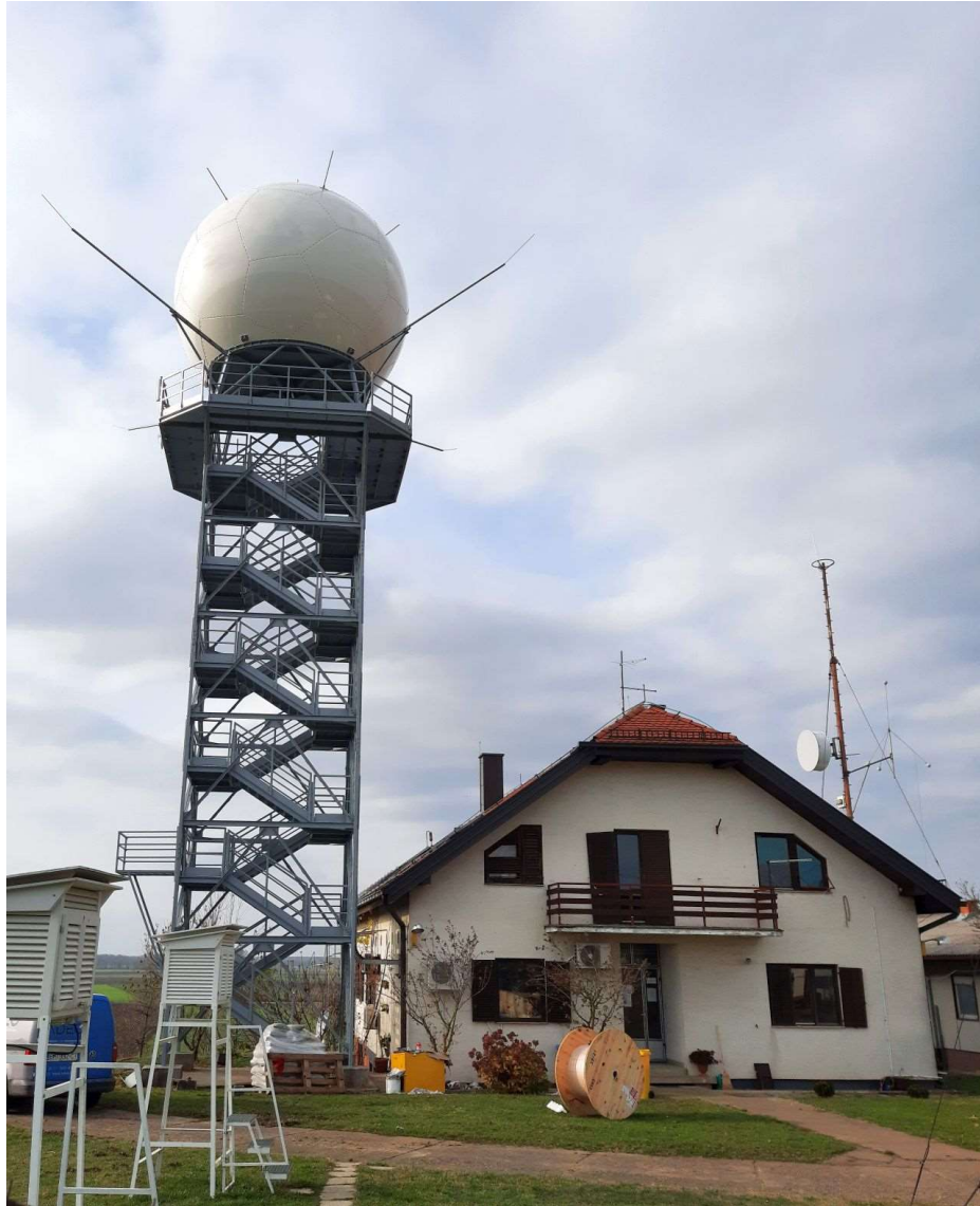
RC-6 Gradište, montiran novi meteorološki radar Vaisala WRM200 i veća kupola (studen 2021.)
