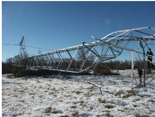
Slika 2.4.2.1. Stup dalekovoda srušen zbog nepovoljnih meteoroloških prilika (iz arhive HEP-a).
